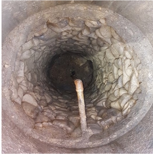
Ziehbrunnenschacht: Geheimnisträger in der Kirchgass (Foto: Pascal Hutter).
