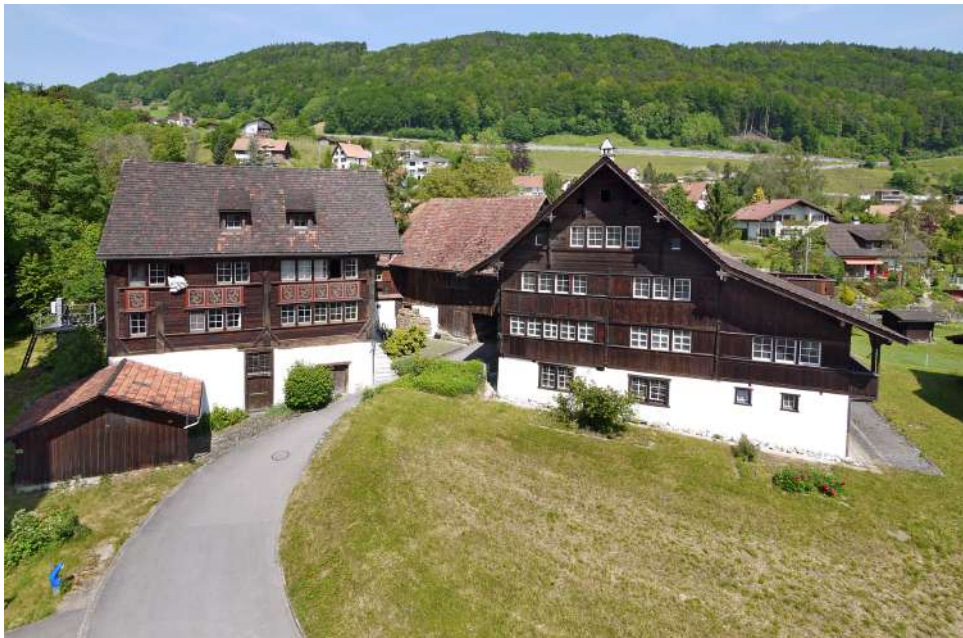
Die Obere Mühle. Das Frei-Haus links beherbergte die Mühle mit dem grossen Wasserrad; rechts davon das Zellweger-Gebäude.
