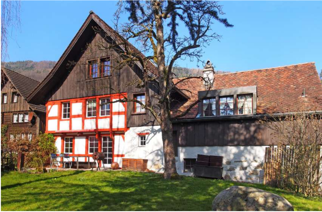
Hinterdorfstrasse 3, Beda Germann, Südfassade
