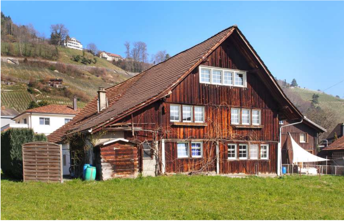
Hinterdorfstrasse 29, Fam. Nigg, Südseite
