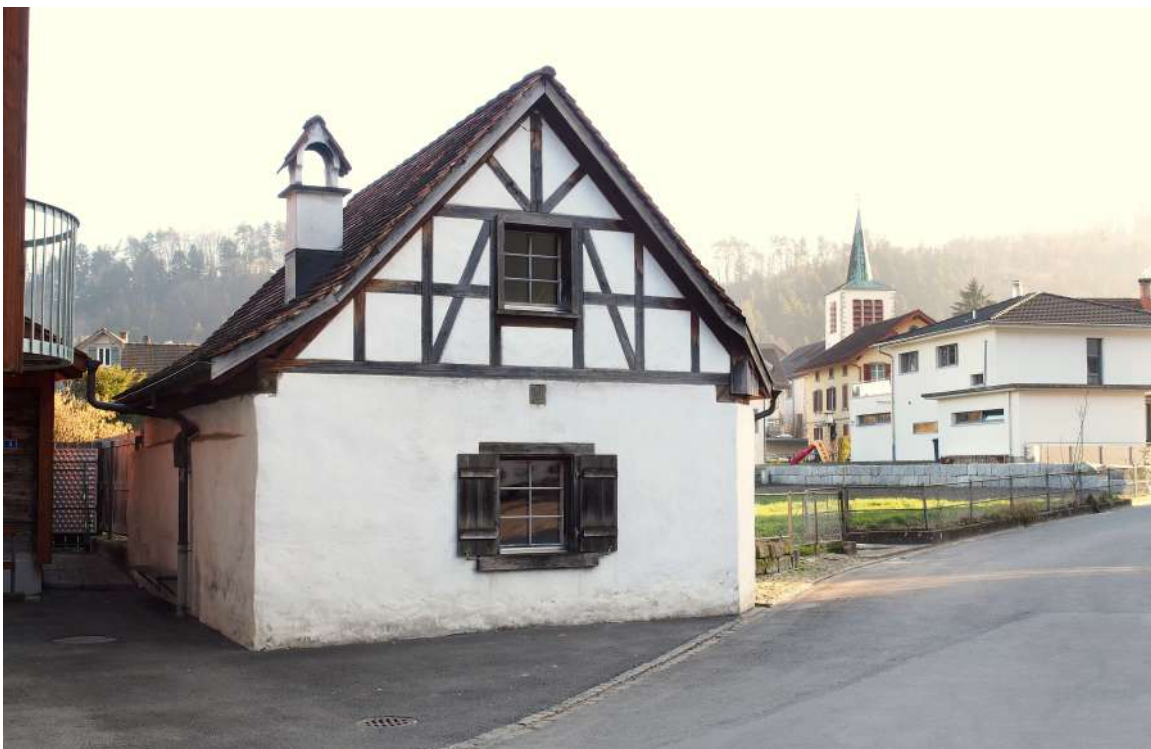
Kübachstrasse, Brennhüsli, bzw. Waschhaus, Nordseite
