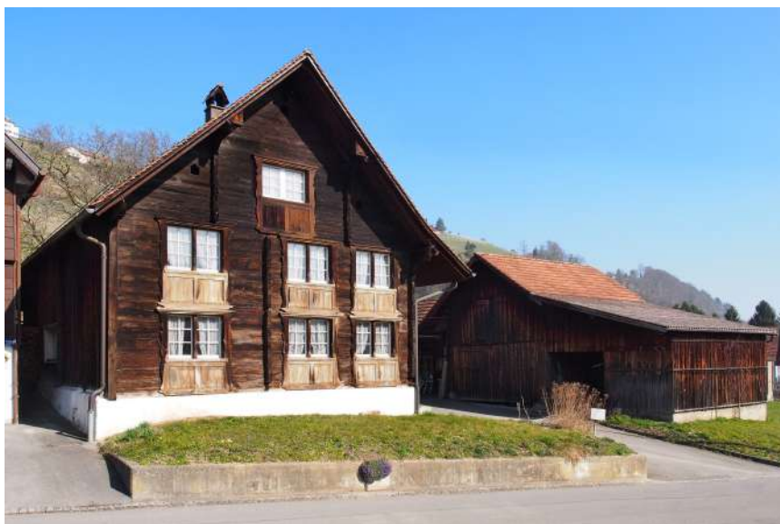
Hinterdorfstrasse 10, Hansueli Dierauer, Ansicht von Süden
