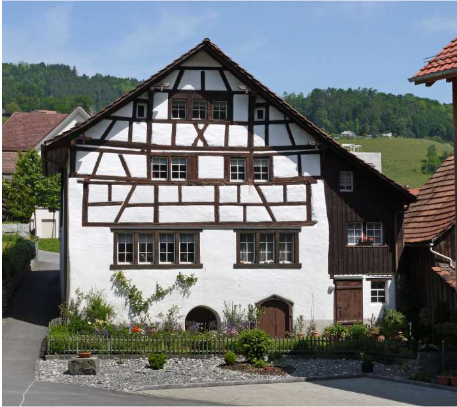
Die Südfassade des Guldenhauses.
