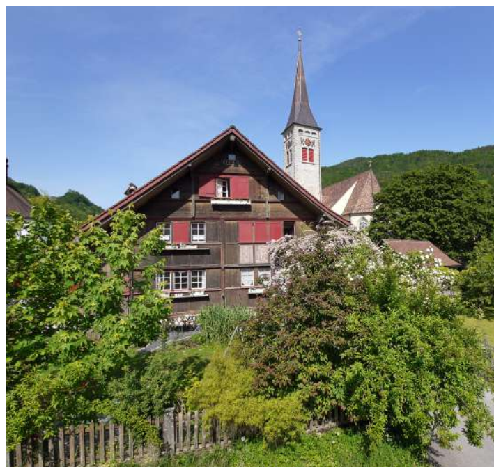
Die Kaplanei, von Osten gesehen.
